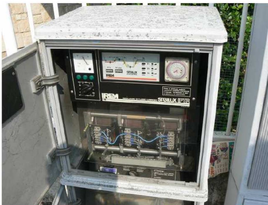
Figura 2 - Regolatore di flusso di via Ortigara
